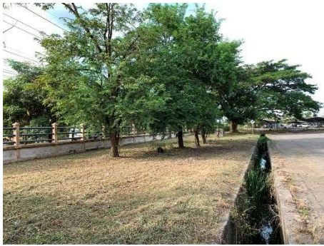
ภาพที่ 2.2-15 รางระบายน้ำฝน ขนานไปกับแนวรั้วรอบพื้นที่โรงงาน
